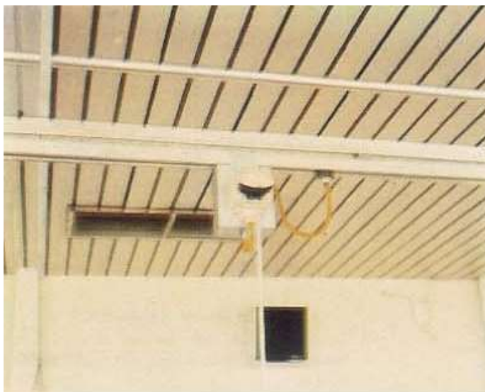
Slika br. 14 – Kutija sa šuko-priključnicom bez osigurača
