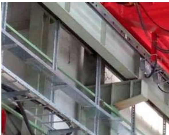
Za unutrašnju primenu, ELVOD nudi sisteme nosača kablova koji su galvanski ili hladno pocinkovani. Ovi sistemi naročito pogoduju suvoj atmosferi prostorija bez uticaja agresivnih štetnih materija.
